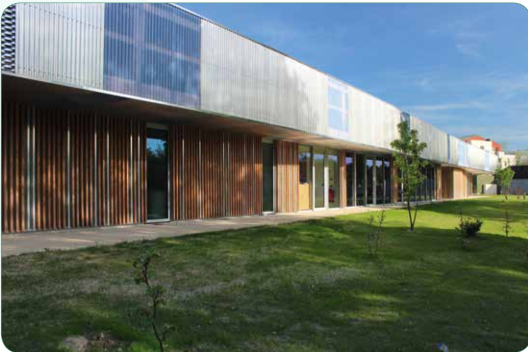
Façade Nord-Ouest © Colomes Nomdedeu
